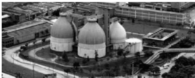
Figura 11. Planta San Fernando, Municipio de Itagüí. Fuente: EPM, 2022.
