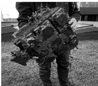
Imagen 1. Estructura para construir terrazas verdes en Dinamarca.
