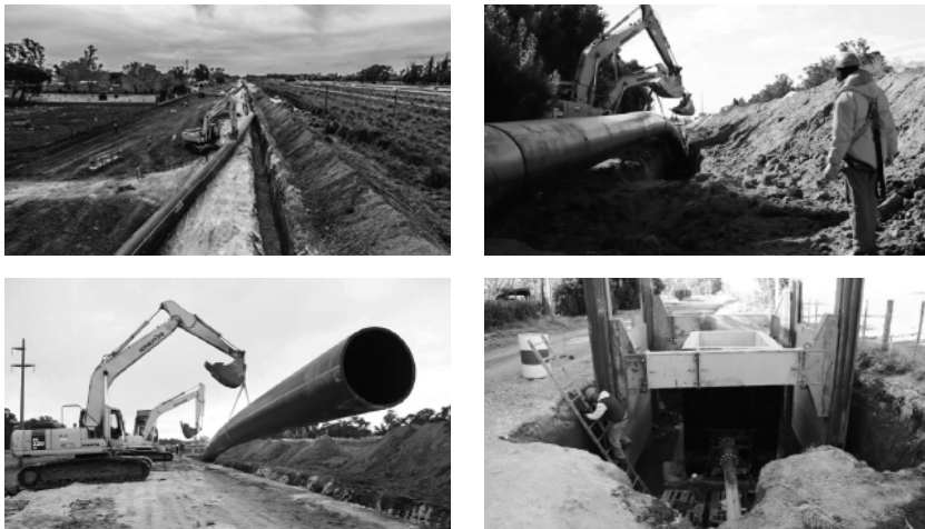
Figura 2. Imágenes de las obras de SAO I.
